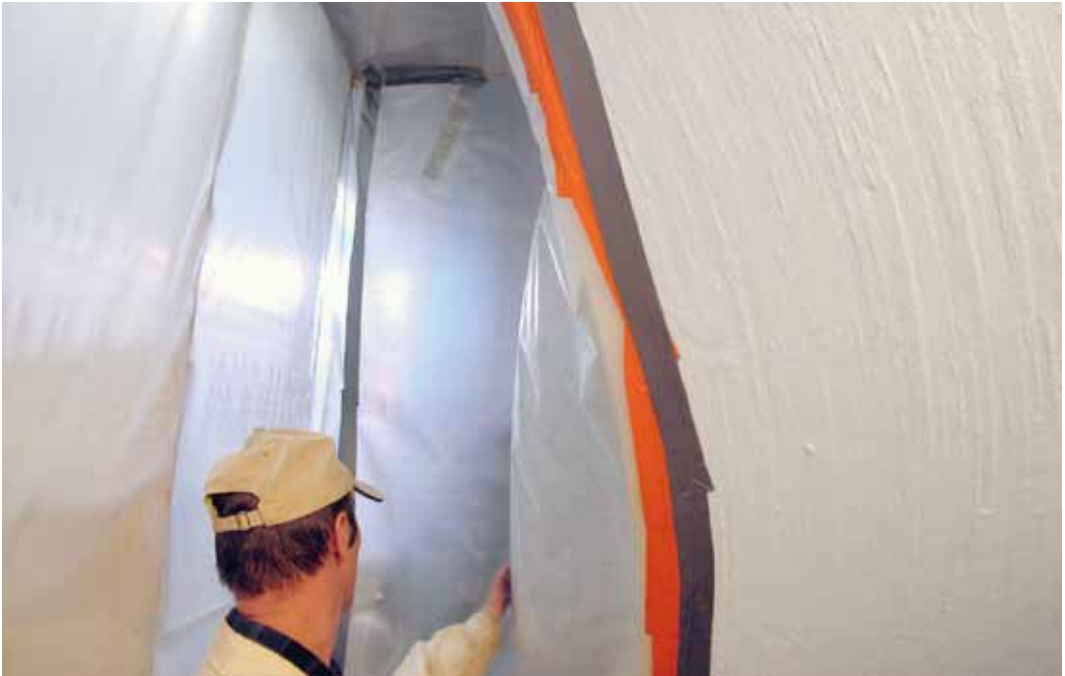
Osastointi rakennettuna porrassyöksyn alle. Huom. sisäänpäin imeytyvät muoviseinämät
