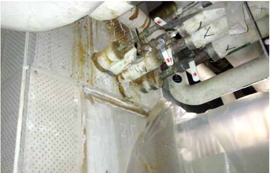
Asbestiesiintymiä rakennuksessa
