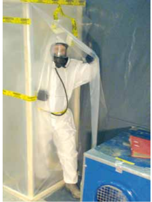
Sulun oven rakenne
