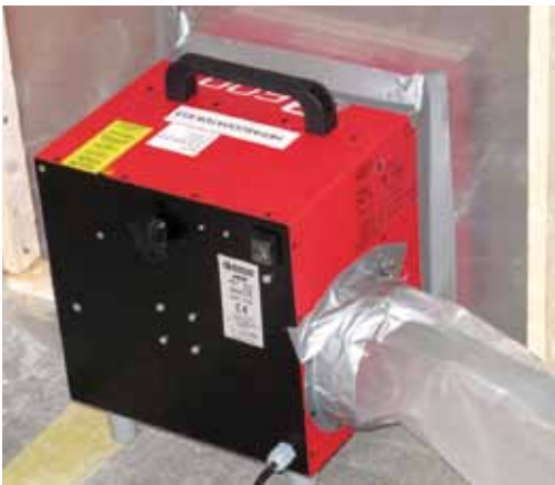
Alipaineistaja toiminnassa ja alipaineistajan suodatin
